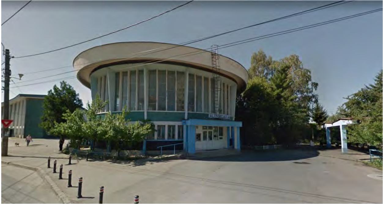
Figură 2-40 - Corp principal Autogara Baia Mare
