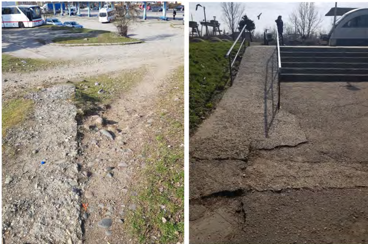
Figură 2-60 - Imagini reprezentative zona Autogării și Gării - Lipsa rampelor sau prezența rampelor incorect proiectate
