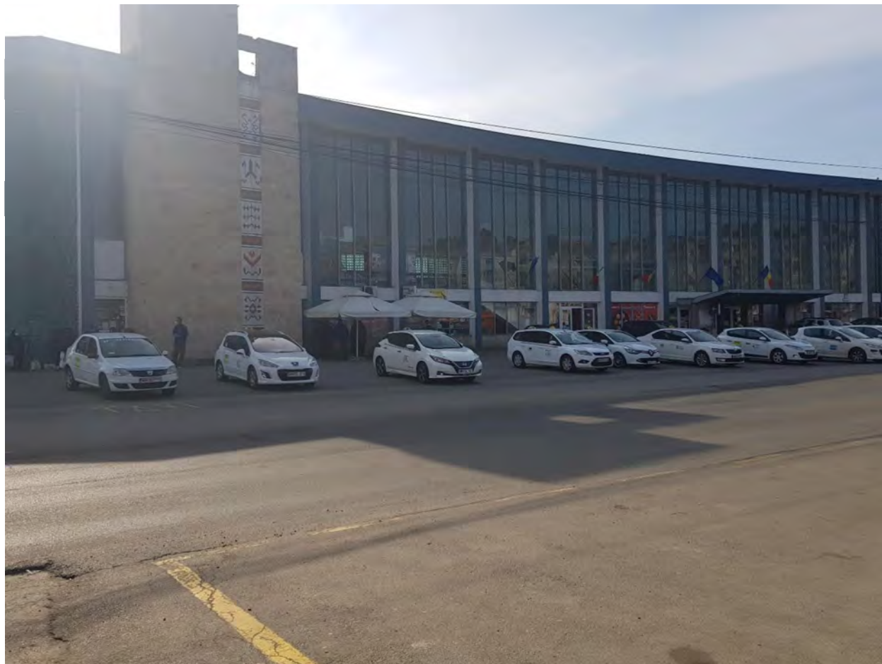
Figură 2-51 - Gara Baia Mare - Stație de Taxiuri
